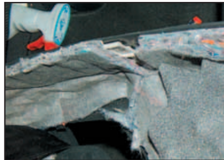
Vorsorglich: Alle Abdeckungen werden mit Dämmvlies und Noppenschaumstoff ausgekleidet.
