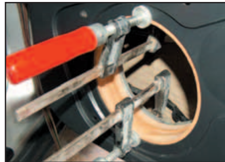
Zwingend: Die verklebten MDF-Ringe halten die Verkleidung unter Spannung.
